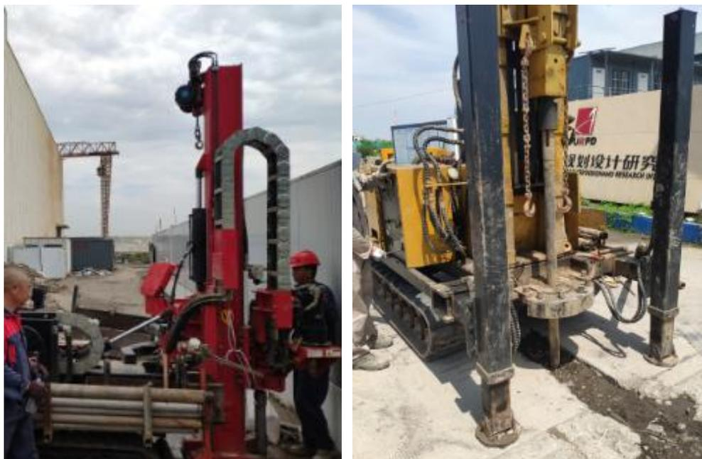
图 5-2 土壤钻探作业图
