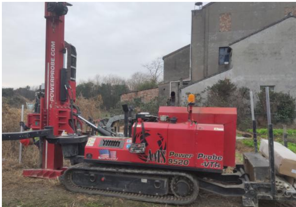
图 5-2 土壤钻探作业图
